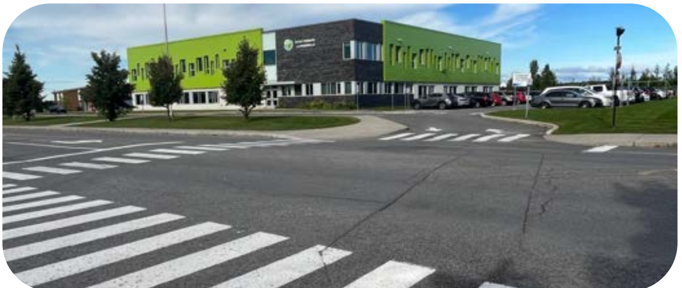
Figure 34 – Traverses piétonnes à proximité de l'école Vert-Demain
