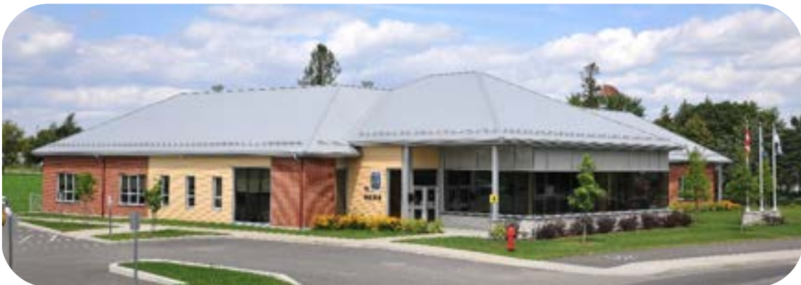
Figure 5 – Nouvelle mairie de Saint-Paul
